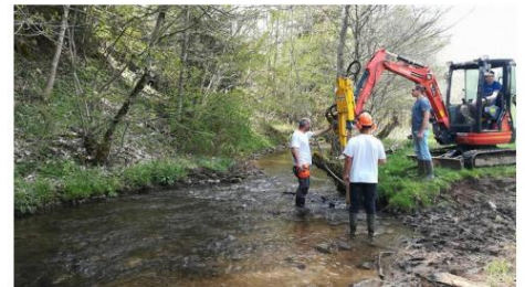
2 : Enfoncement des pieux avec la mini-pelle et l'enfonce-pieu
