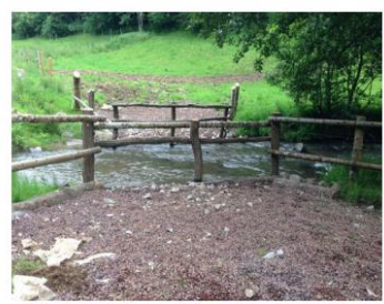
7: Abreuvoir terminé avec pouzzolane et clôture
