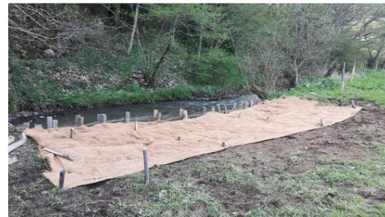
6 : Retaille des pieux et opération terminée !
