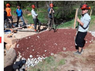
5- Mise à niveau des rampes d'accès
