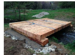
4- Mise en place du tablier
