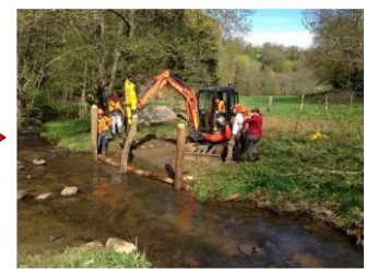
2 : Enfoncement des pieux
