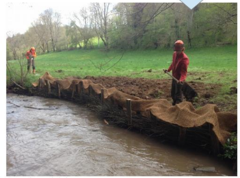
4 : Retalutage de la berge
