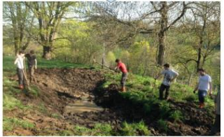
4: Façonnage des berges à la pelle puis à la main
