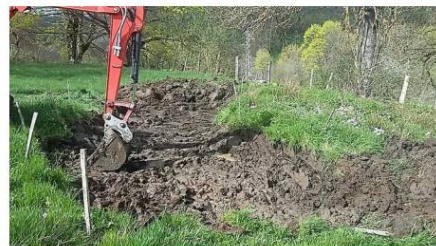
2: Creusement de la mare à la mini pelle
