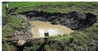
6: Pose des pieux, de la ligature et création d'habitats
