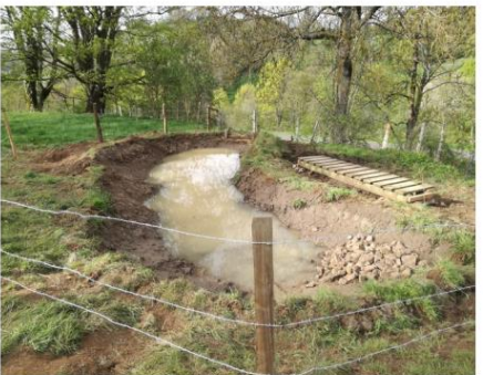
8: Fin des travaux de la nouvelle mare
