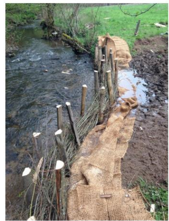
3 : Création d'un méandre, pose de la toile coco et pose des fascines de saules
