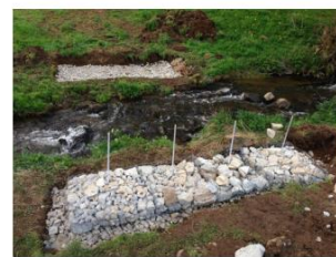
2- Mise en place des fondations (gabions)
